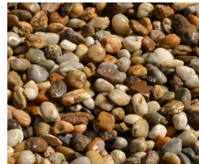
Obr.č.2 – Finální vrstva okapového chodníku
