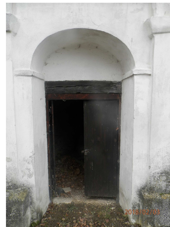
Obr. č. 21 – Detail vstupních dveří márnice
