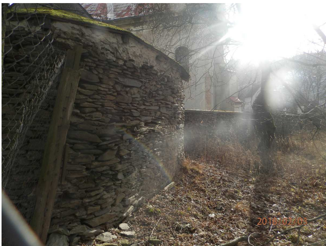
Obr. č. 22 – Pohled na márnici - zadní
