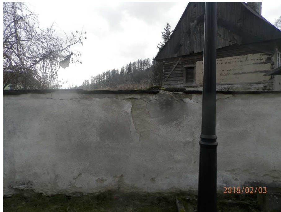
Obr. č. 27 – Detail ohradní zdi se zákrytovou deskou z břidlice
