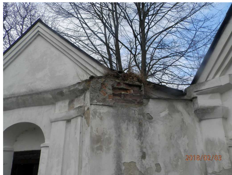
Obr. č. 20 – Márnice - detail římsy (vybourání, dozdění, znovu vytvarování římsy)
