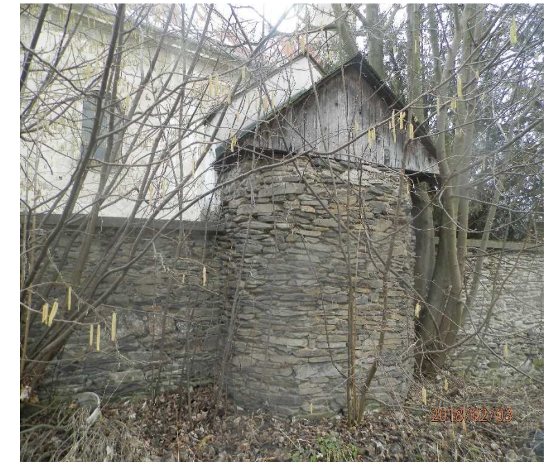
Obr. č. 29 – Pohled na rub ohradní zdi v místě kapličky
