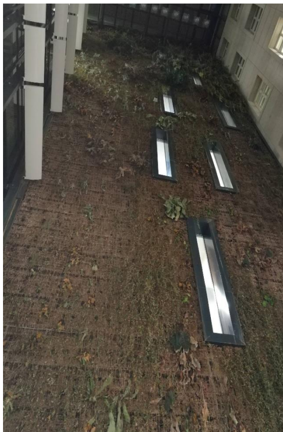
Obr. 3.4: Příklad realizace vertikální zelené stěny v administrativní budově Jindřišská 16 a nedostatečné péče
