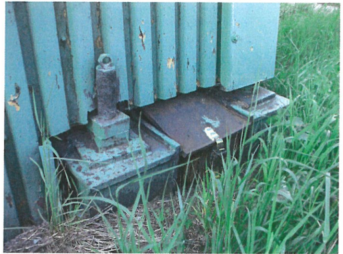
3. SO 4220 Těžní věž jámy č.4 - pohled na kotvení sloupů severní stěny - pravá
