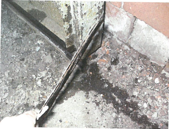
7. SO 4220 Těžní věž jámy č.4 – detail odpadlé zkorodované vrstvy pod nátěrem z prutu rámu OK v přechodu do kotevní patky
