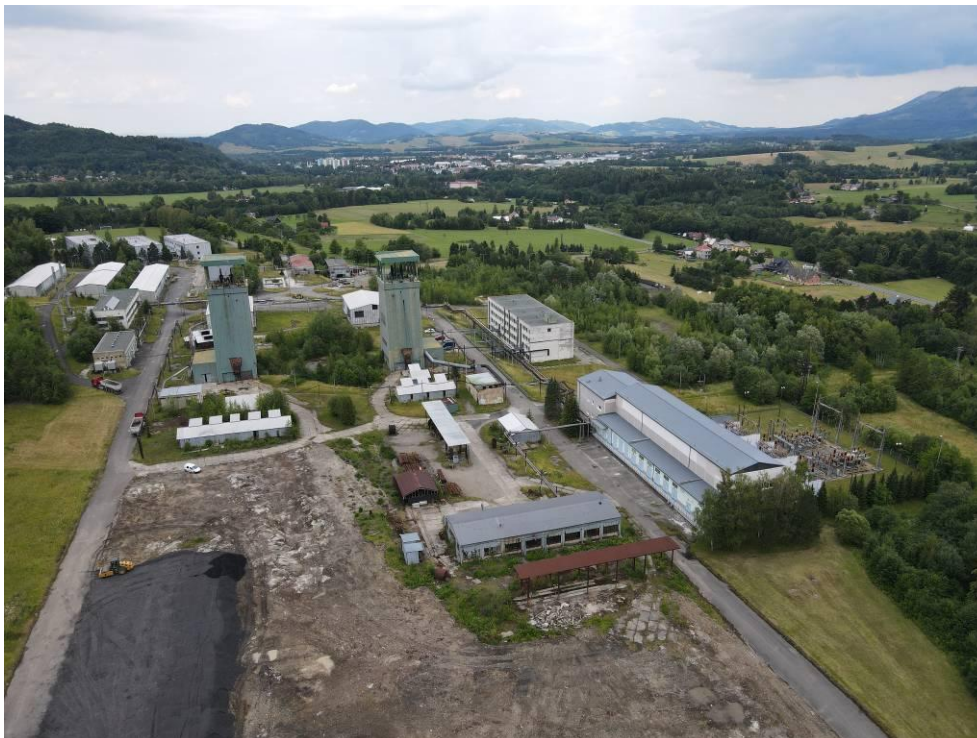
Obr. 6: Letecký pohled na jádro areálu bývalého dolu Frenštát – zastavěná část areálu s budovami a těžebními věžemi.
