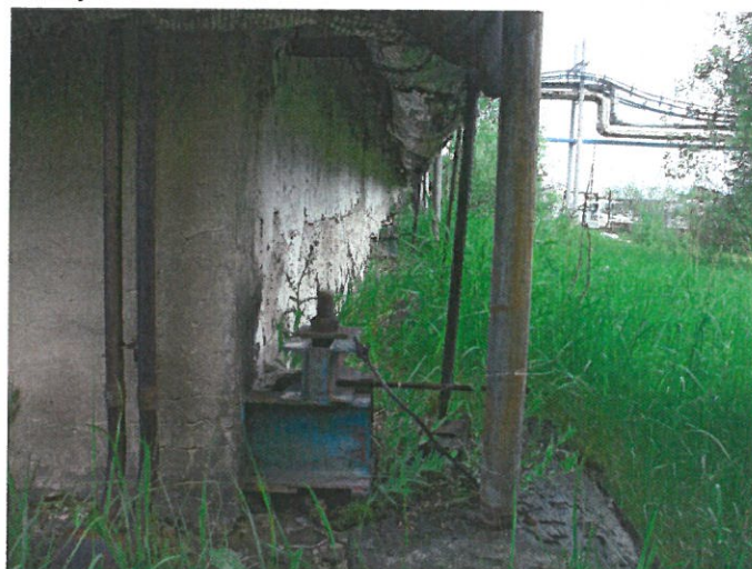
6. SO 5200 Strojovna těžního stroje 2C-6x2,4 – interiér haly – narušený plášť v místě průchodu lana do objektu
