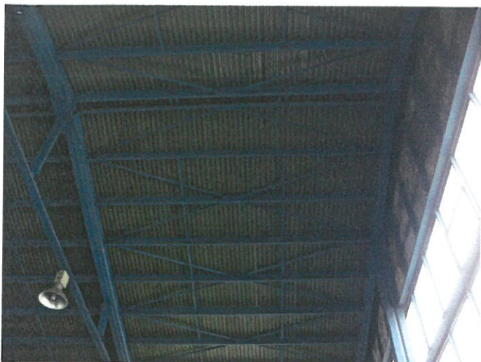
3. SO 5200 Strojovna těžního stroje 2C-6x2,4 – pohled na vazníky a vaznice střechy
