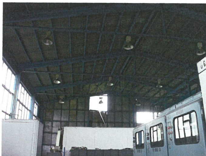
6. SO 5200 Strojovna těžního stroje 2C-6x2,4 – interiér haly – narušený plášť v místě průchodu lana do objektu
