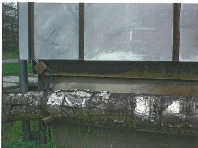
7. SO 5200 Strojovna těžního stroje 2C-6x2,4 – detail soklu s jádrovou omítkou, detail opláštění haly , nadzemní vedení zavěšeno na soklu
