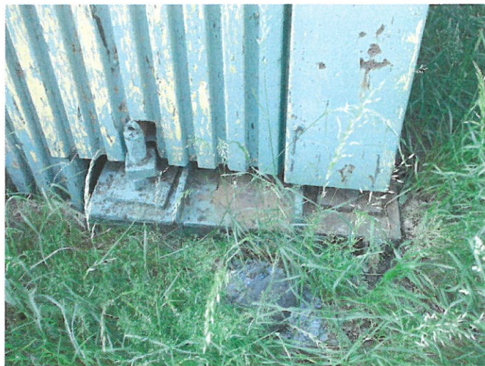
2. SO 5220 Těžní věž jámy č.5 - pohled na kotvení sloupů severní stěny - pravá
