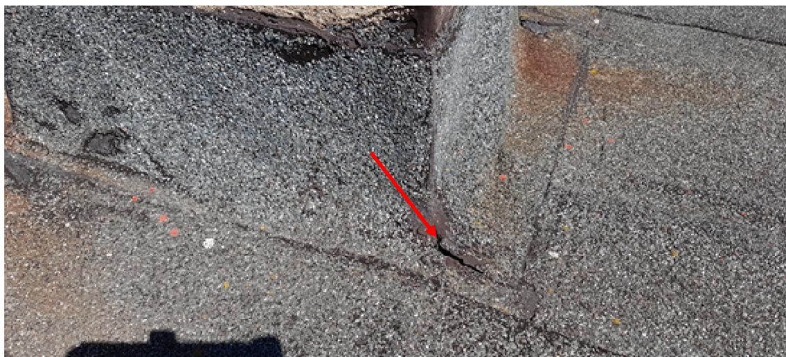
Obr. 145 Nesoudržný spoj asfaltových pásů
