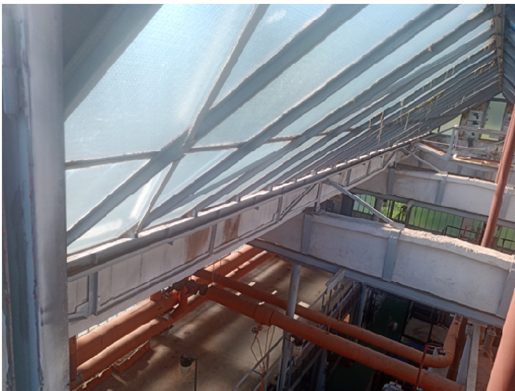
Obr. 77 Střešní plnostěnné vazníky a pohled do světlíku
