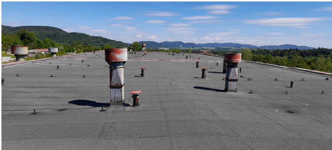
Obr. 140 Pohled na střešní krytinu
