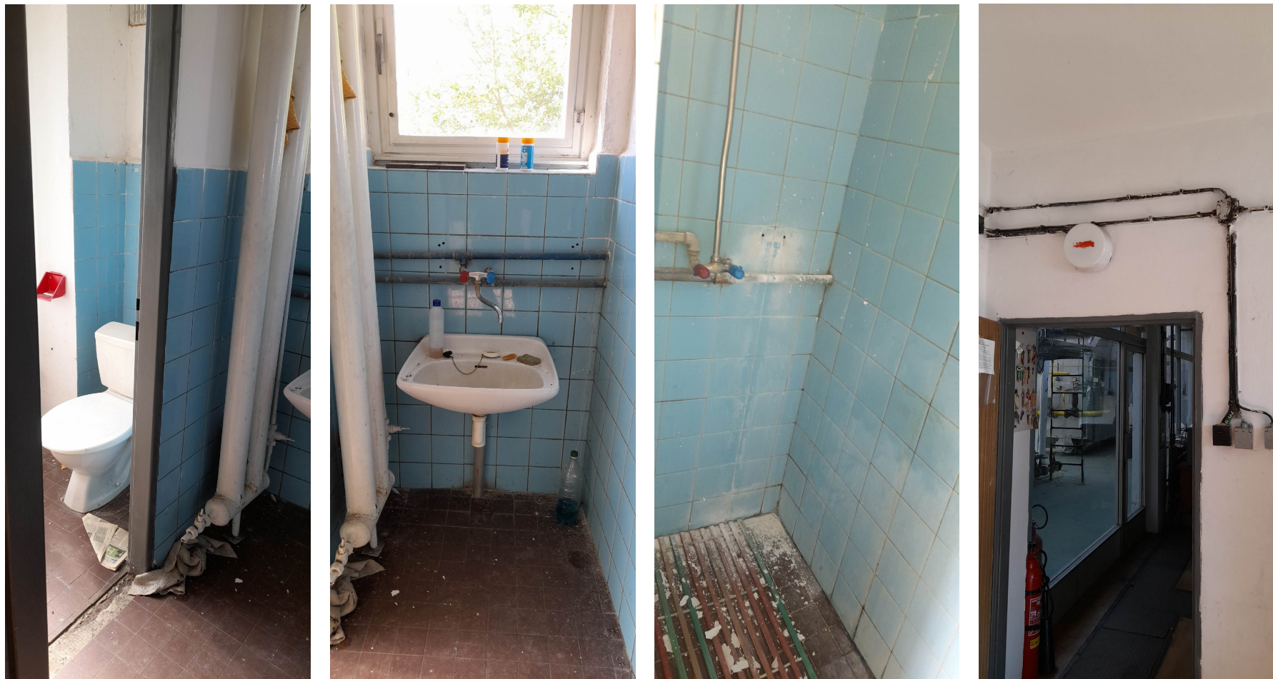
Obr. 99, 100, 101, 102 Technické zařízení budovy – zázemí pro personál – za fyzickou i morální životností
