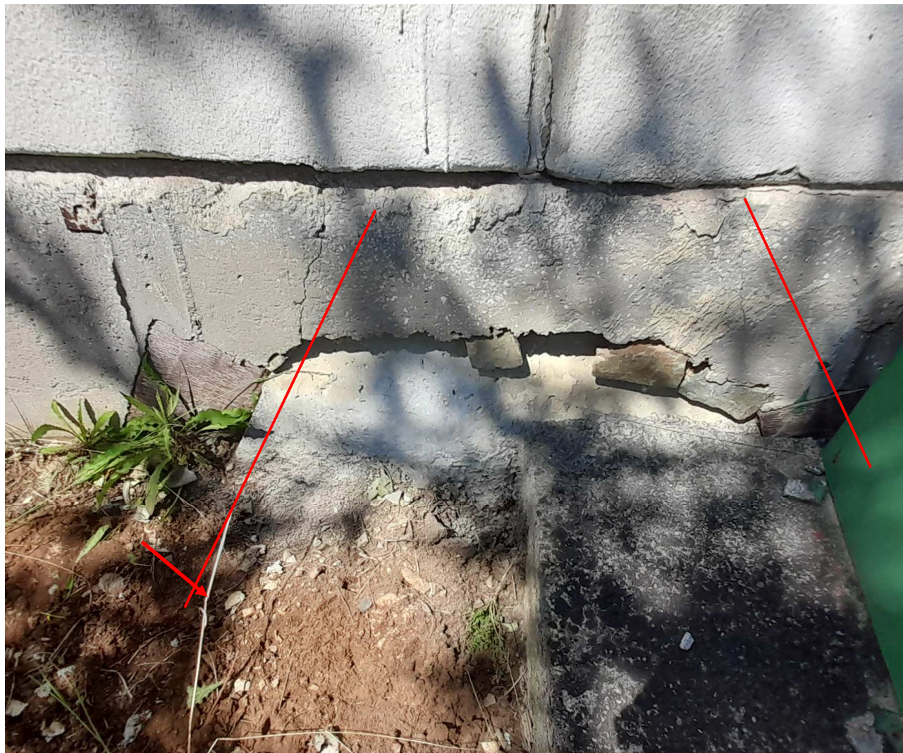
Obr. 53 a 54 Viditelný sloup s průběhem přes 2 patra, vypraskaný spoj panelů, zešíklená patka s návaznými základovými pasy
