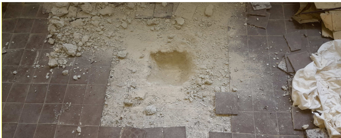
Obr. 138 Sonda do podlahy 2.NP / stropu 1.NP
