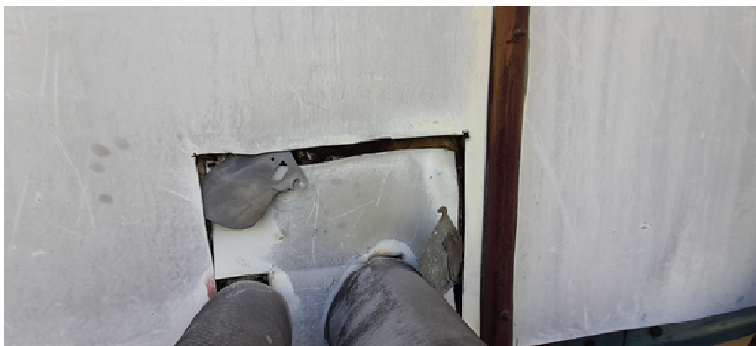
Obr. 125 Místo odběru vzorku ze zateplení obvodového pláště
