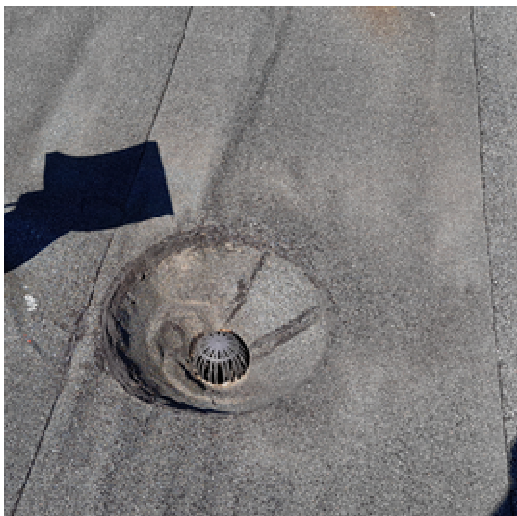
Obr. 142 a 143 Dešťové vpusti částečně vyměněné, částečně původní
