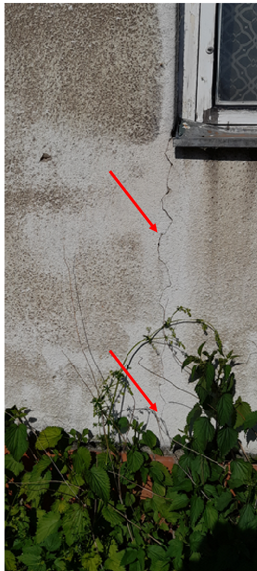
Obr. 169 a 170 Vypraskaná omítka i panel pod omítkou – prasklina směřuje ke kabřincem zakrytým základům
