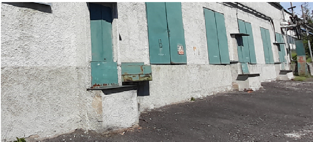
Obr. 104 Soklová část základu
