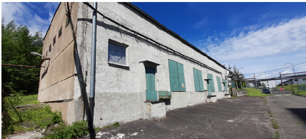
Obr. 103 Řešený objekt SO4360 – jihovýchodní pohled
