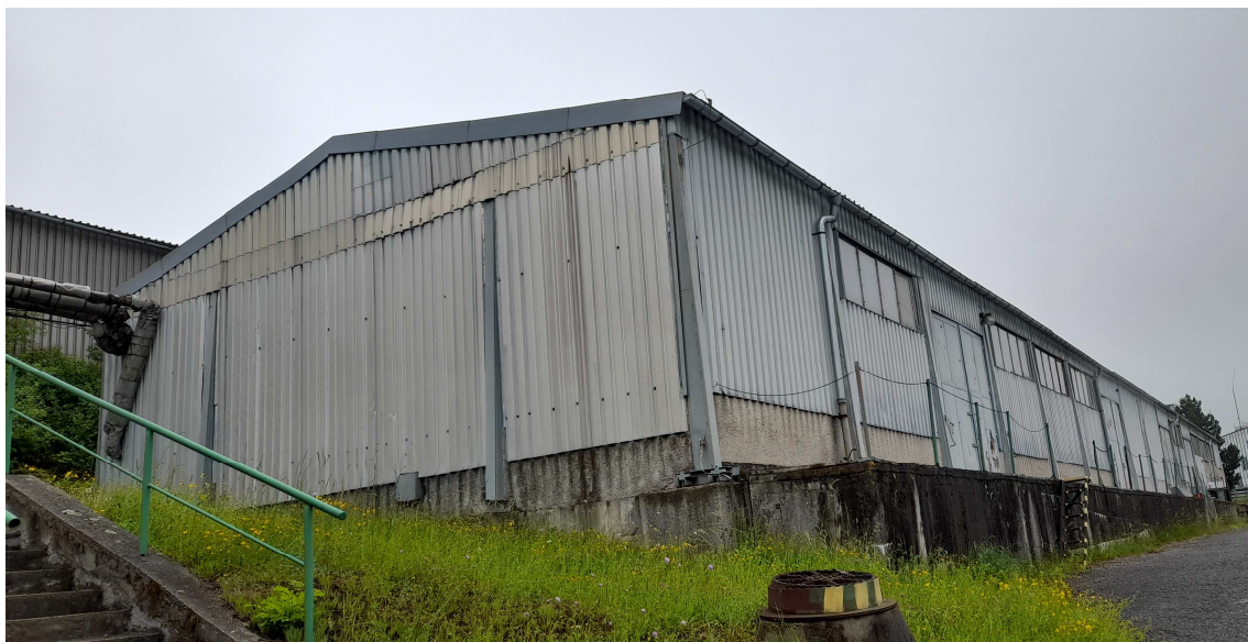
Obr. 27 Řešený objekt SO103 – jihovýchodní pohled
