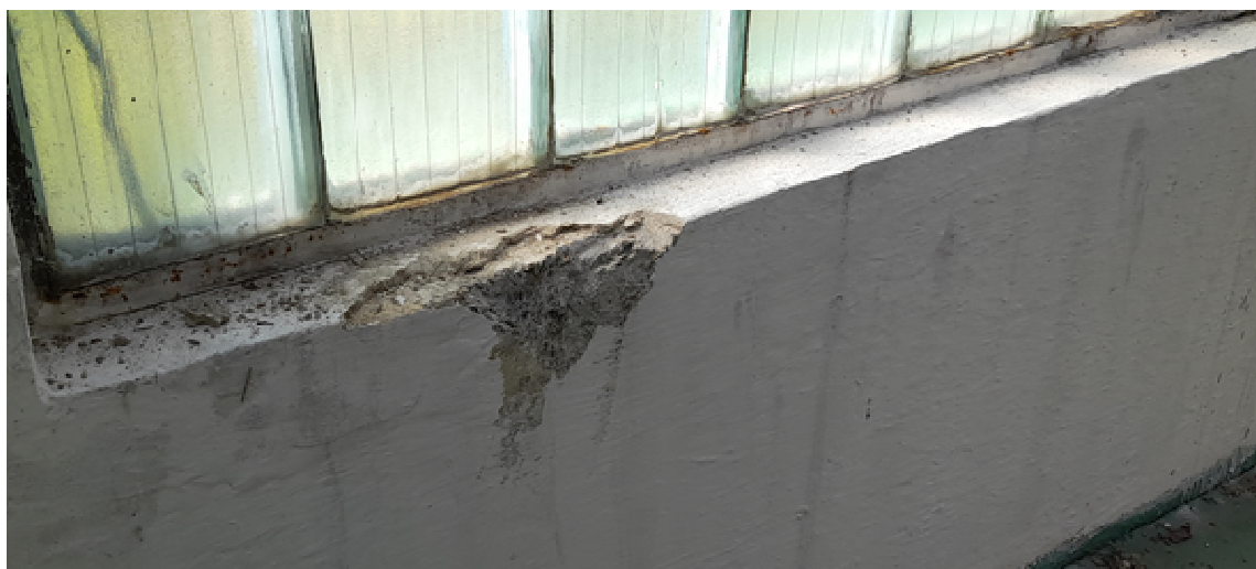
Obr. 64 Sonda ke zjištění materiálu obvodové konstrukce
