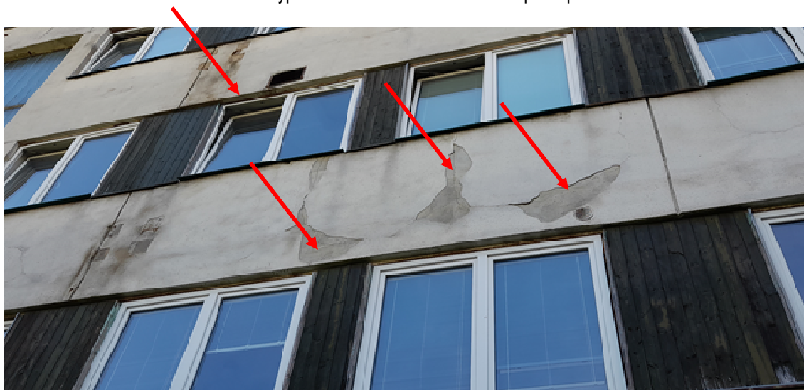
Obr. 155 Vypráskaná a nesoudržná (opadaná) omítka v ploše panelu
