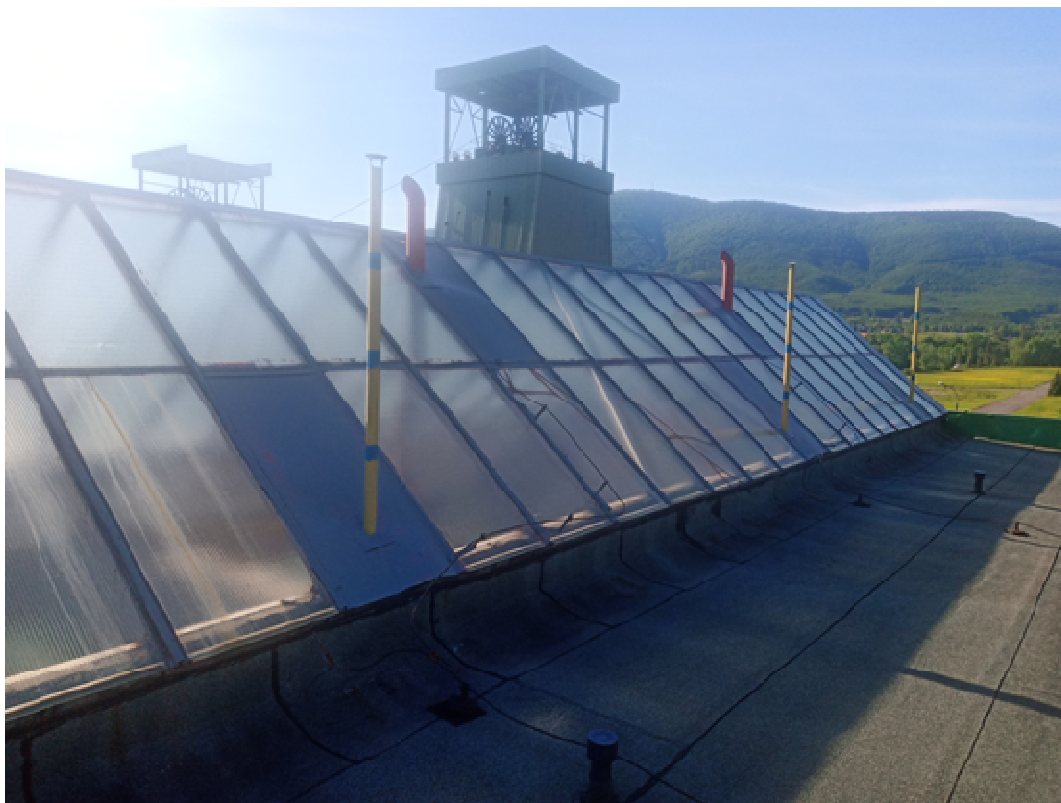
Obr. 73 Střešní světlík na jižní polovině střechy hlavní budovy
