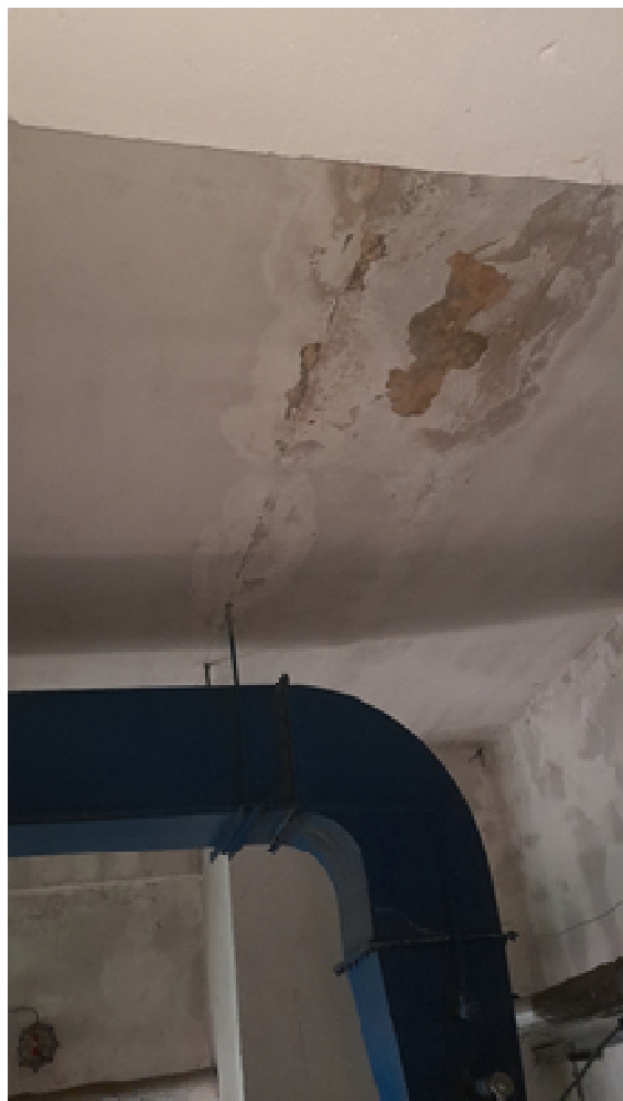
Obr. 80, 81, 82 Vlhkostní poruchy v přístavku – pravděpodobně stále aktivní zatékání střešním pláštěm
