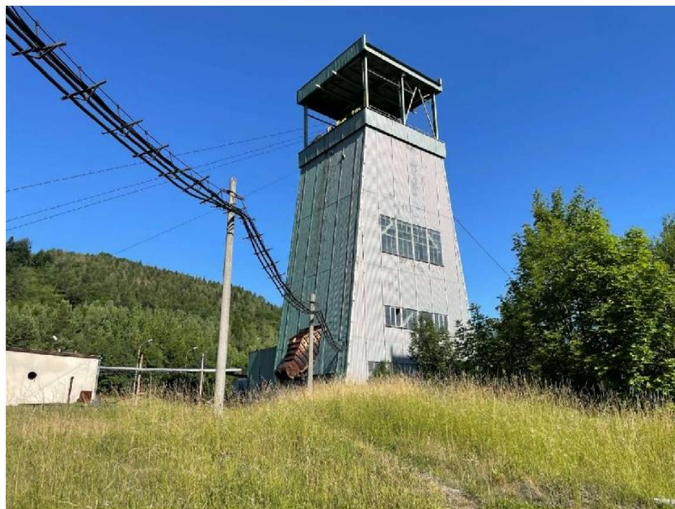
Celkový pohled – těžní věž č. 5
