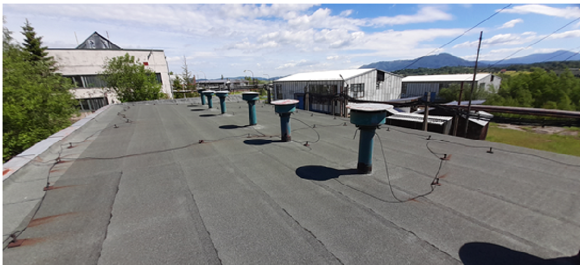
Obr. 112 Původní klempířské prvky odvětrávání
