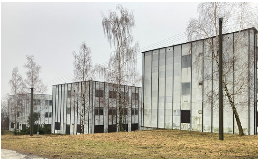
Obr. 7 Řešené objekty 151, 152, 153 – severozápadní pohled
