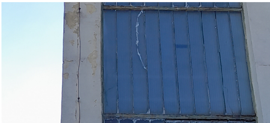
Obr. 172 Prosklení schodišť sklotvárnici COPILIT
