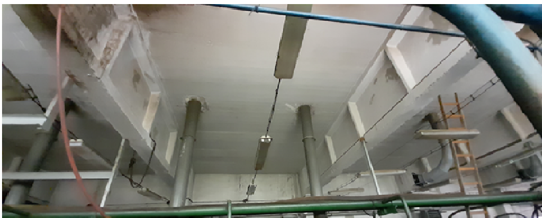
Obr. 108 Pohled na střešní ŽB nosníky a dutinové panely jsou v dobrém stavu
