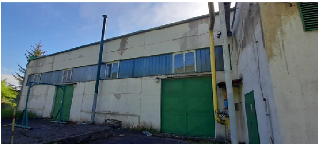
Obr. 97 Plechová vrata odpovídají charakteru objektu – pro nové využití objektu nejspíše nevyužitelné
