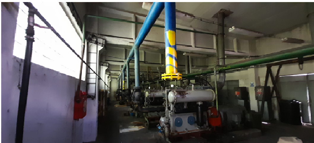
Obr. 107 Celkový pohled na nosný systém
