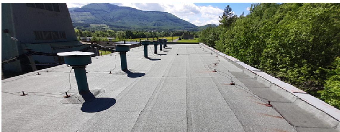
Obr. 110 Střešní krytina (asfaltové modifikované pásy) ve velmi dobrém stavu
