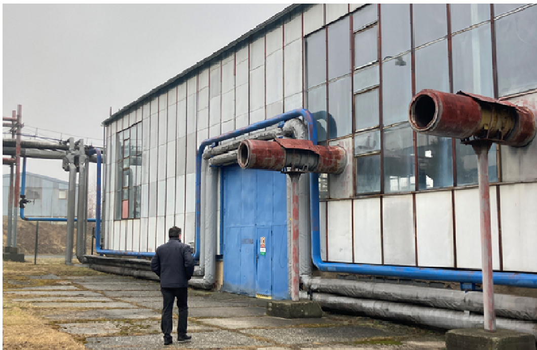
Obr. 119 Řešený objekt SO5200 – jihozápadní pohled
