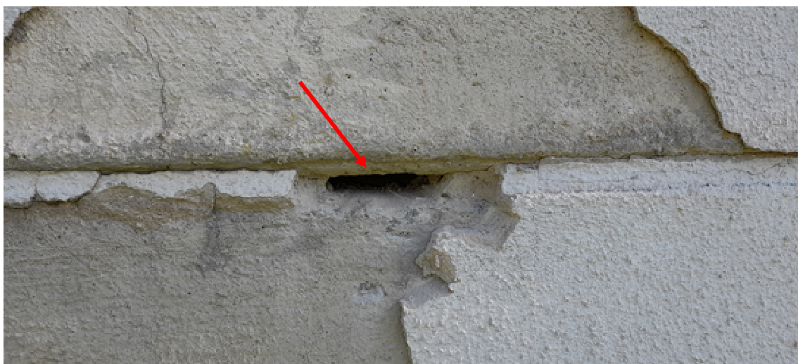
Obr. 163 Sonda do jižní fasády ke zjištění skladby obvodového pláště
