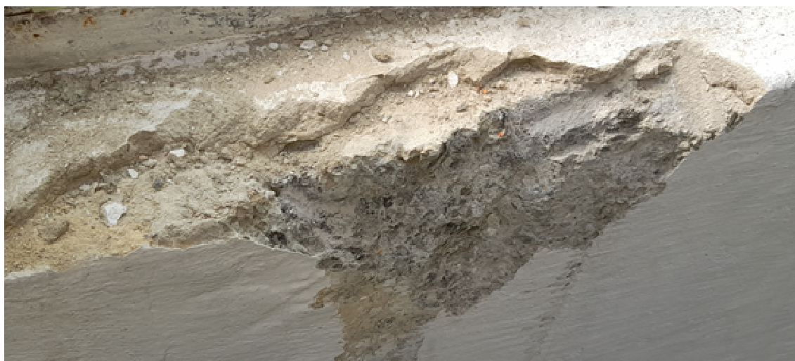
Obr. 65 Sonda ke zjištění materiálu obvodové konstrukce – jedná se o struskopemzobetonové panely
