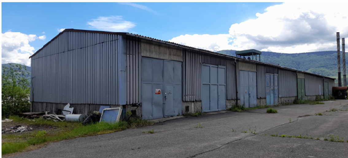
Obr. 34 Řešený objekt SO104 – severozápadní pohled
