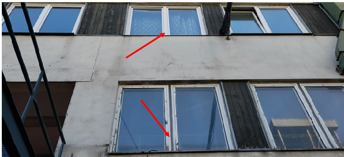
Obr. 171 Část výplní okenních otvorů je po výměně za plastová okna, část původní dřevěná
