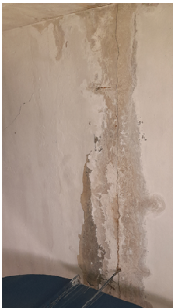
Obr. 80, 81, 82 Vlhkostní poruchy v přístavku – pravděpodobně stále aktivní zatékání střešním pláštěm
