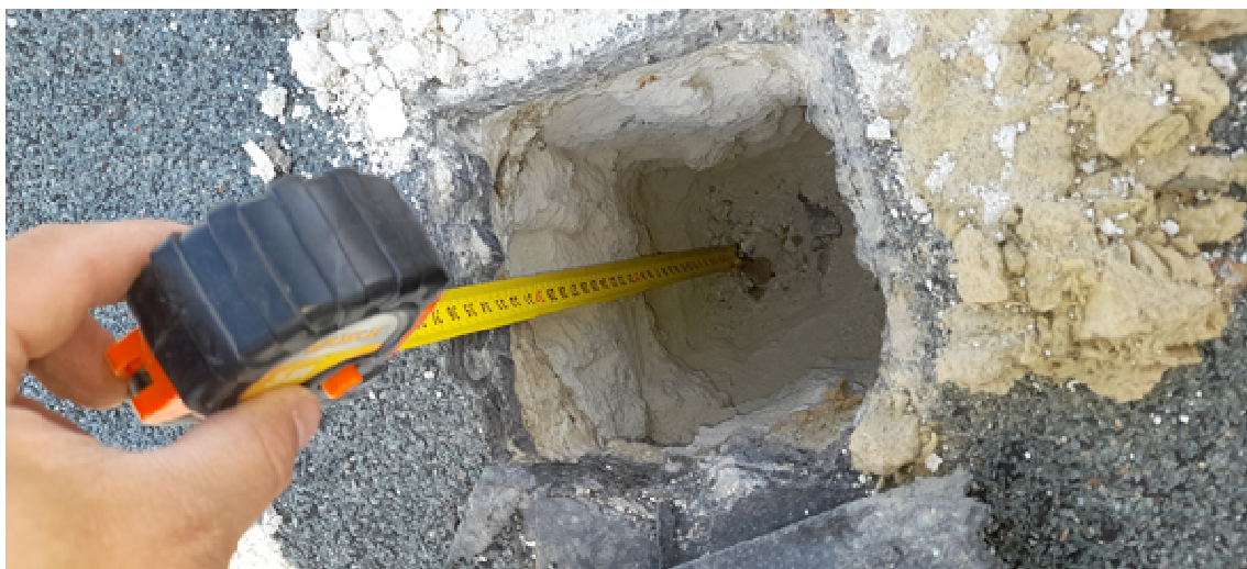
Obr. 148 Sonda do střešního pláště
