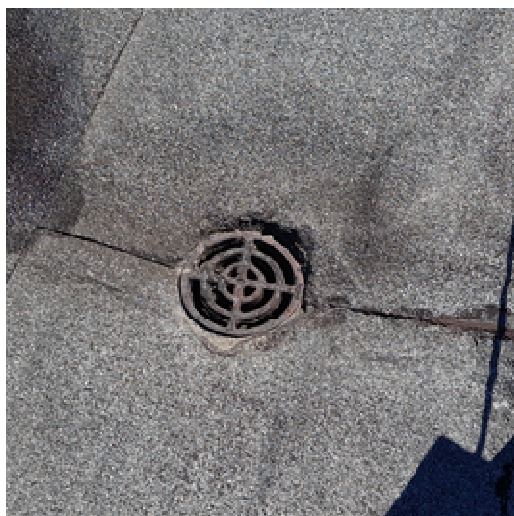
Obr. 142 a 143 Dešťové vpusti částečně vyměněné, částečně původní
