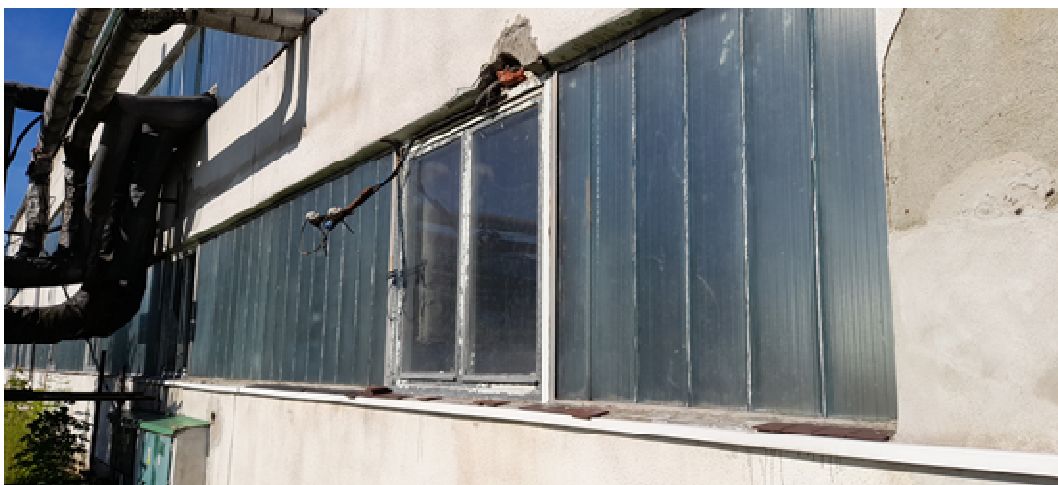
Obr. 95 Původní okna a prosklení COPILIT - pro nové využití objektu spíše nevyužitelné
