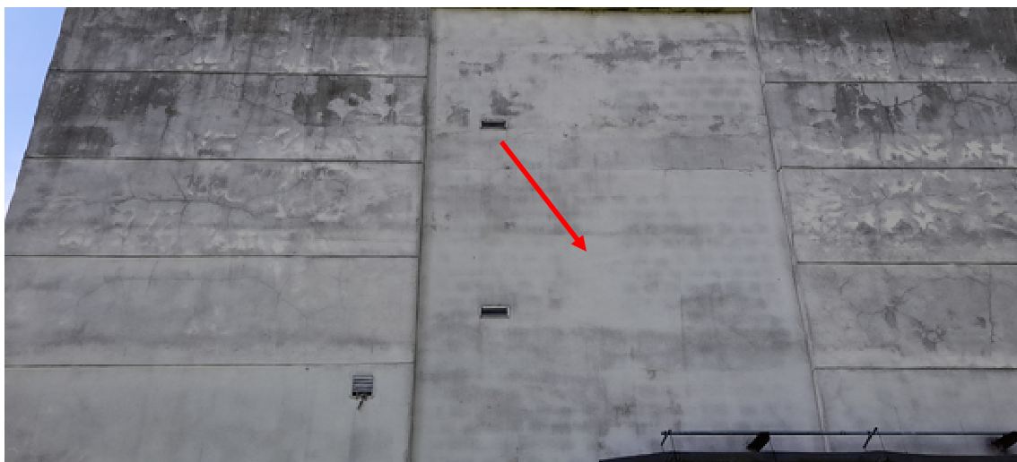
Obr. 159 Středová část jižní a severní fasády je vyzděna z plynosilikátových tvárnic
