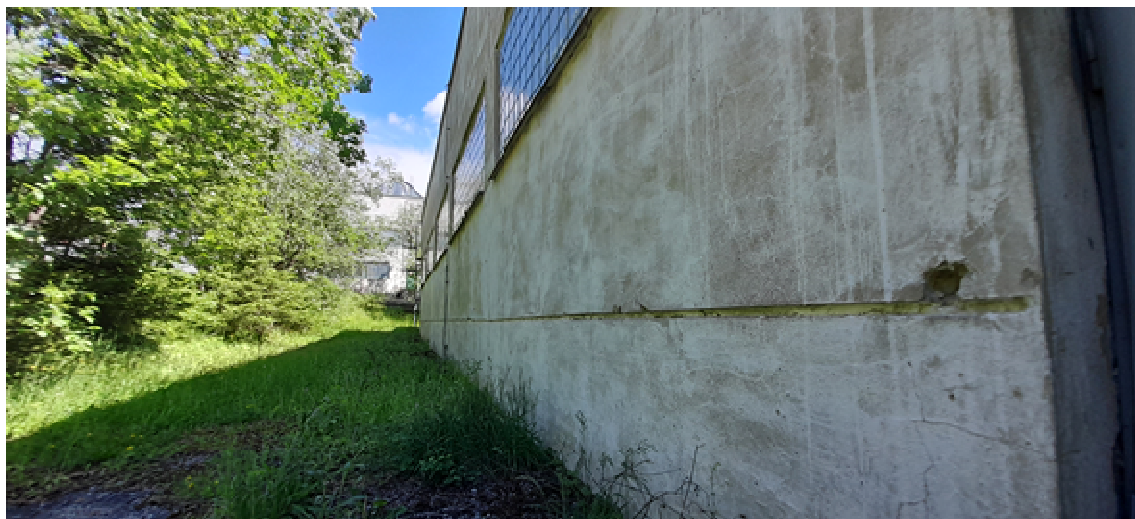
Obr. 113 Nesoudržná a vypráskaná fasáda
