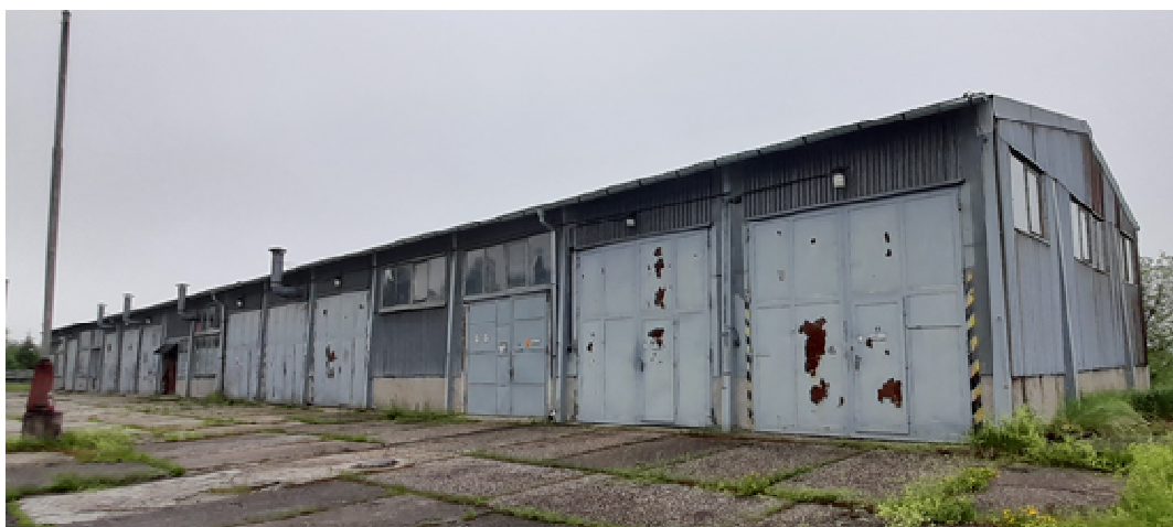
Obr. 15 Řešený objekt SO102 – jihozápadní pohled
