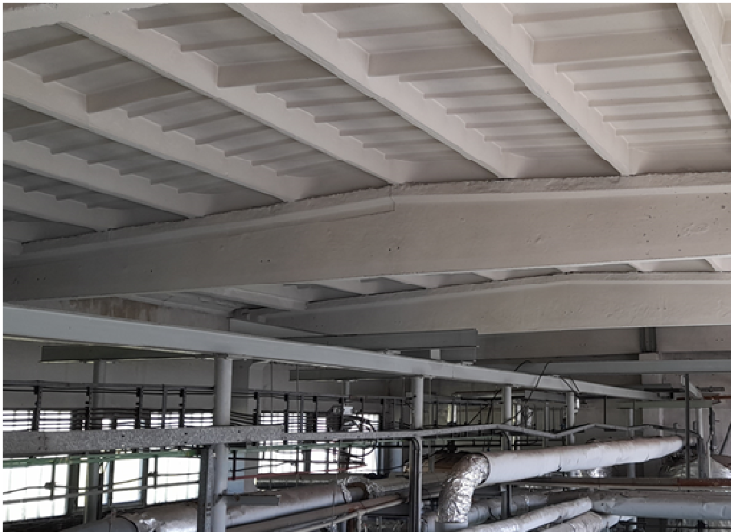
Obr. 56 Střešní plnostěnné vazníky a žebříkové ŽB panely
