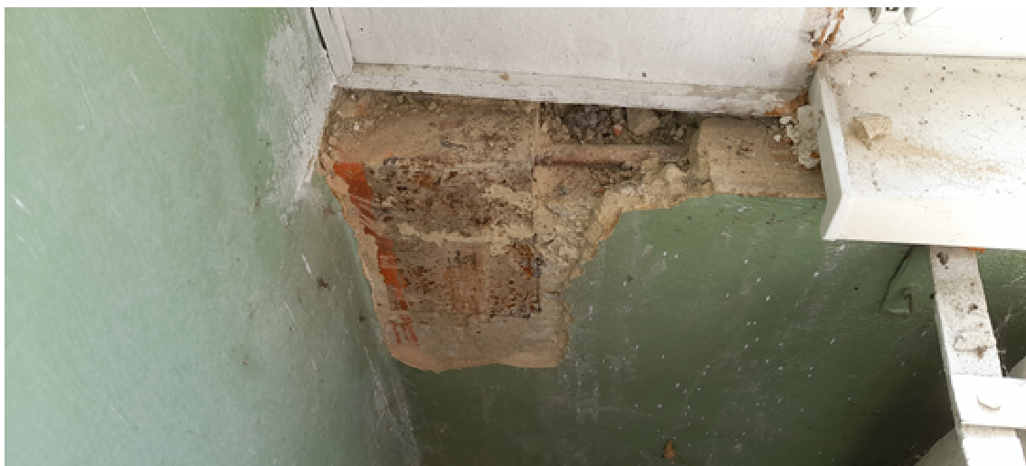
Obr. 162 Sonda do podokenního panelu z interiéru
