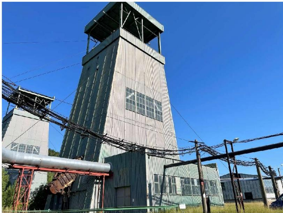
Celkový pohled – těžní věž č. 4
