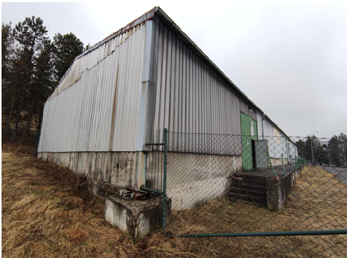
Obr. 40 Řešený objekt SO105 – jihovýchodní pohled
