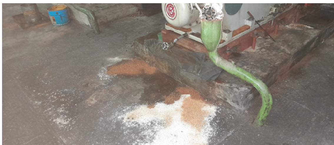
Obr. 117 Olejová skvrna na podlaze
