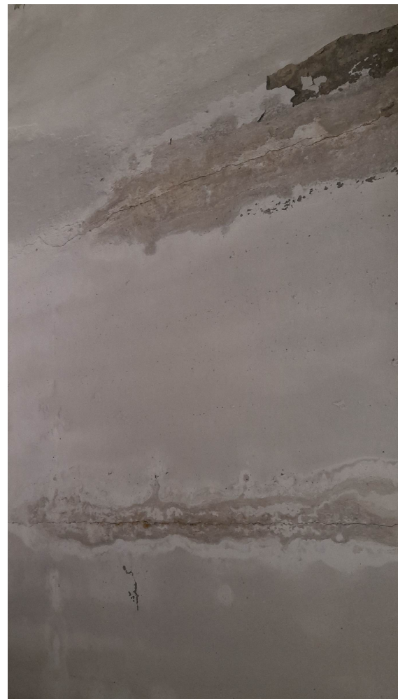
Obr. 80, 81, 82 Vlhkostní poruchy v přístavku – pravděpodobně stále aktivní zatékání střešním pláštěm
