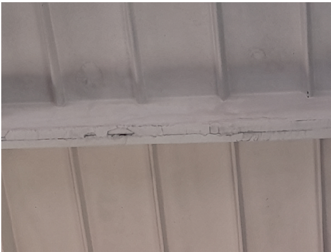
Obr. 57 Střešní prefabrikované železobetonové žebříkové panely - spoj 2 panelů
