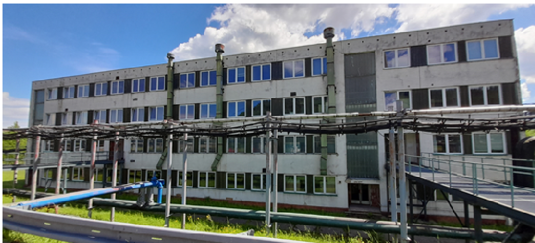
Obr. 126 Řešený objekt SO160 – západní pohled
