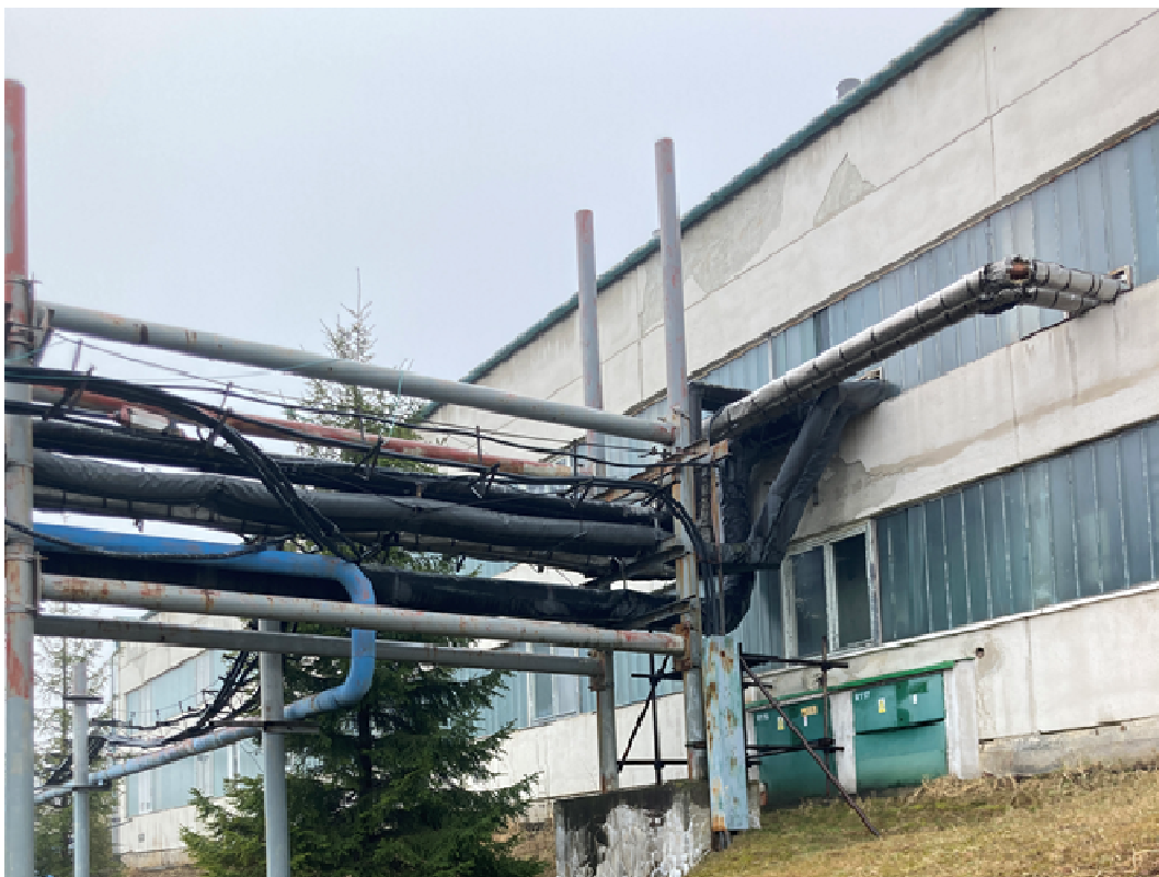
Obr. 45 Řešený objekt SO106 – severovýchodní pohled
